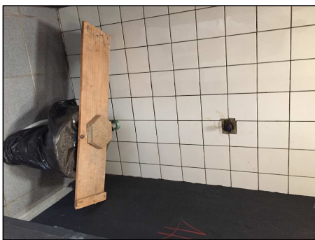
Foto 07: Válvula de descarga com conjunto. Substituir por válvula de descarga com conjunto.
