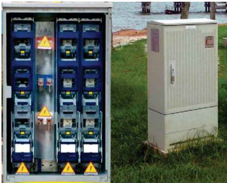
Figura 6 - QDP - Quadro de Distribuição Pedestal
