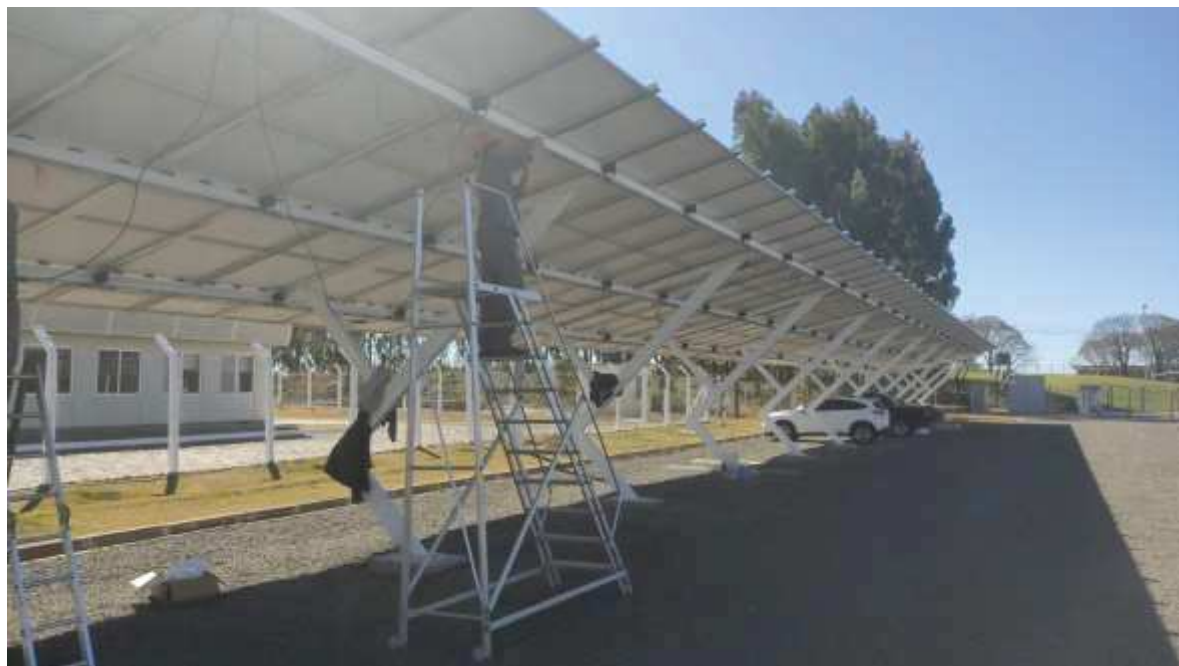
Figura 1 – Fixação em Estrutura Metálica para Estacionamento Solar Fonte: Revolution Estruturas Metálicas
